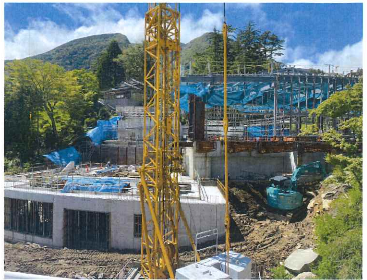
上棟式を終えて、建設が進む紫微宮
