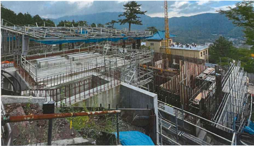
建設が進む紫微宮
