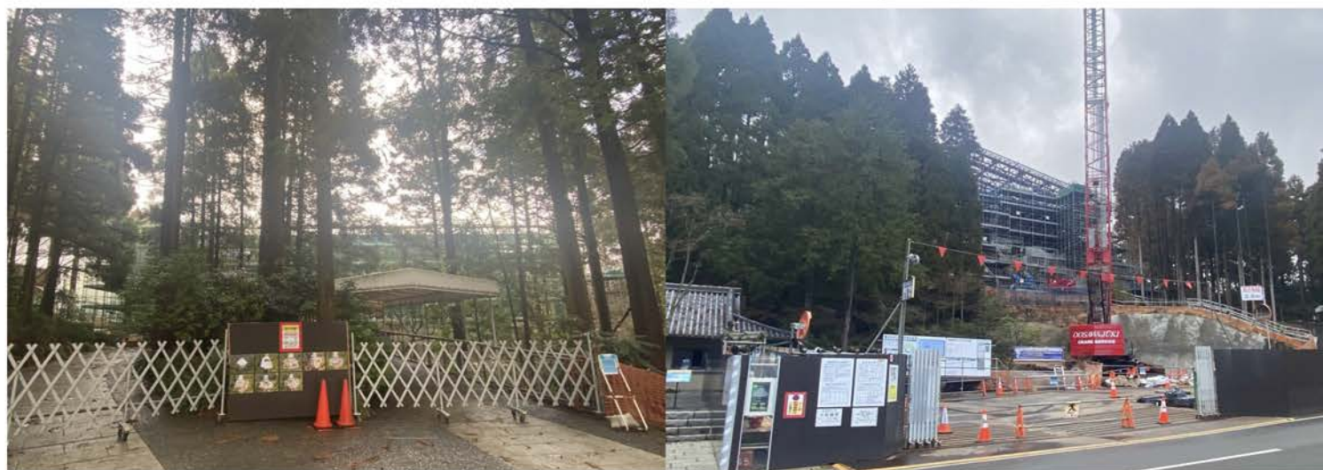
着々と進む光明会館建設
