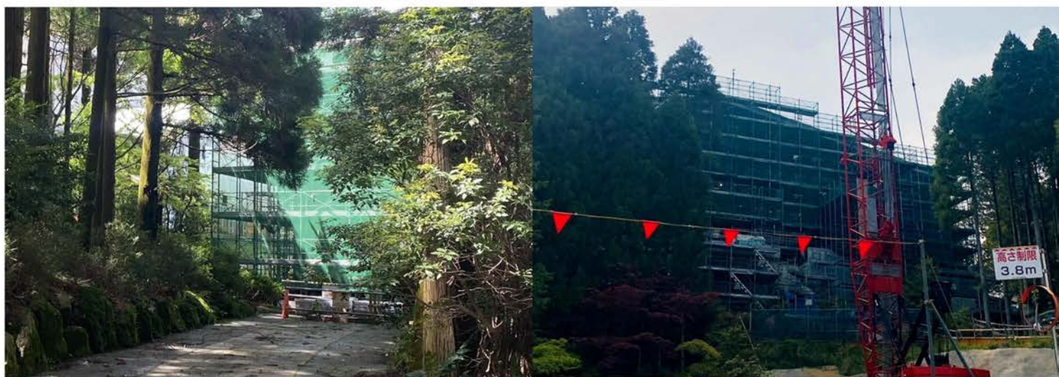
着々と進む光明会館の建設
