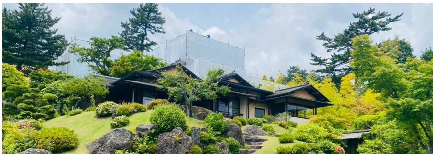
箱根美術館本館（観山亭後ろ）の改修工事が進む
