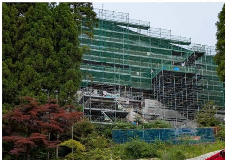
着々と進む光明会館の建設
