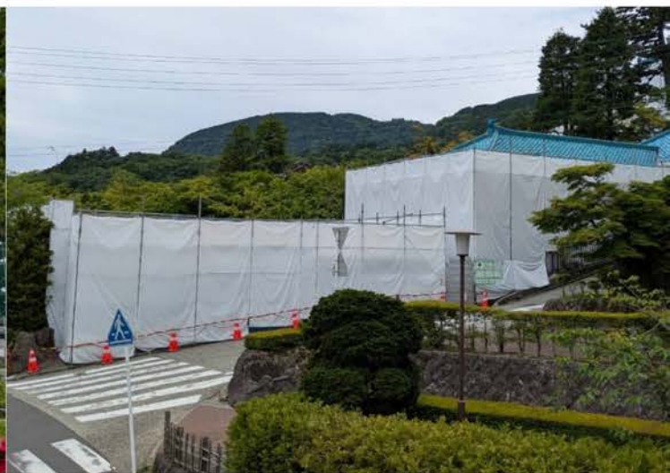
箱根美術館の改修工事も同時進行
