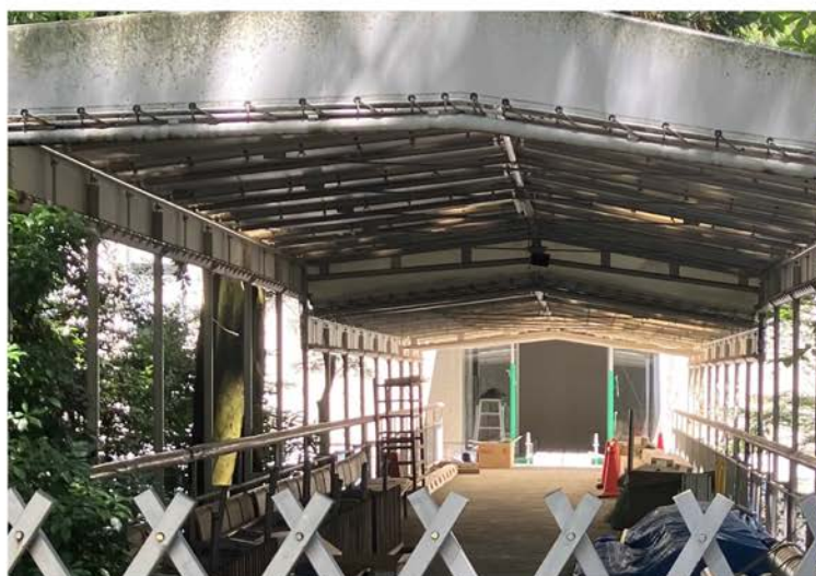
着々と建設が進む光明会館
