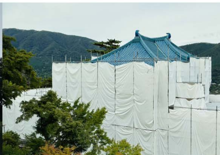
箱根美術館の改修工事も着々と進む
