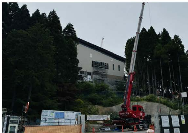
外観がほぼ出来上がり、館内の施工が進む光明会館
